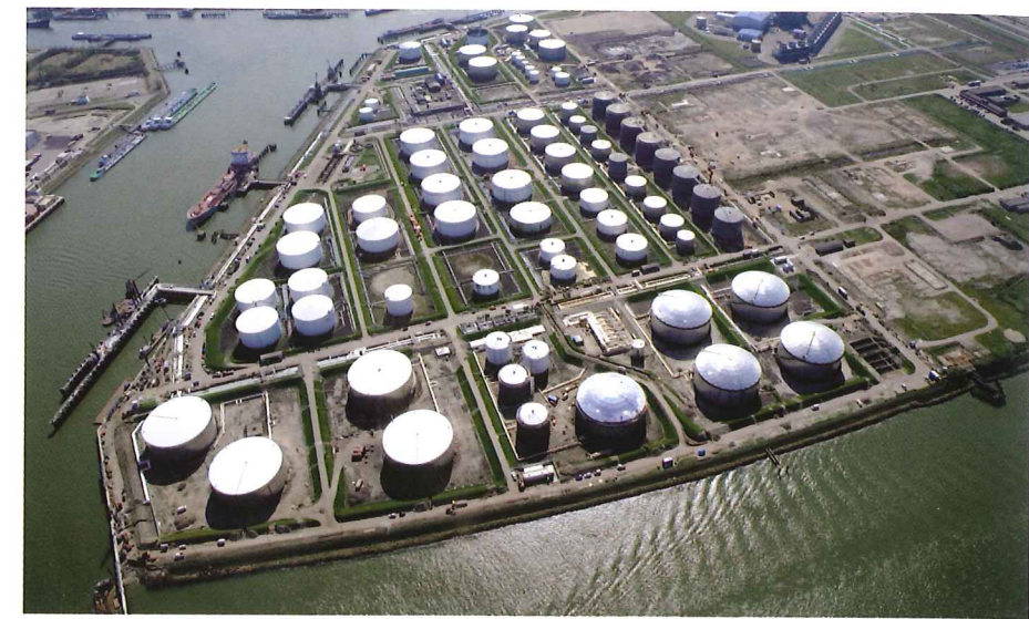
14 dieser Tanks für Argos Oil im Rotterdamer Hafen hat Verwater gebaut.
